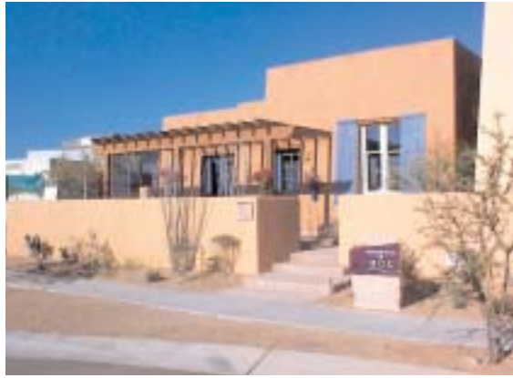
Civano, Arizona. Porch transition zone.
